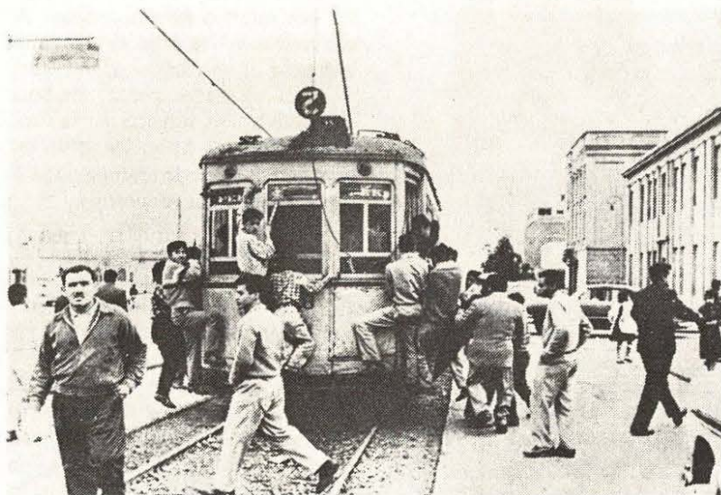
UN acequión, una vía de tren, una línea de tranvía, ahora el zanjón.
